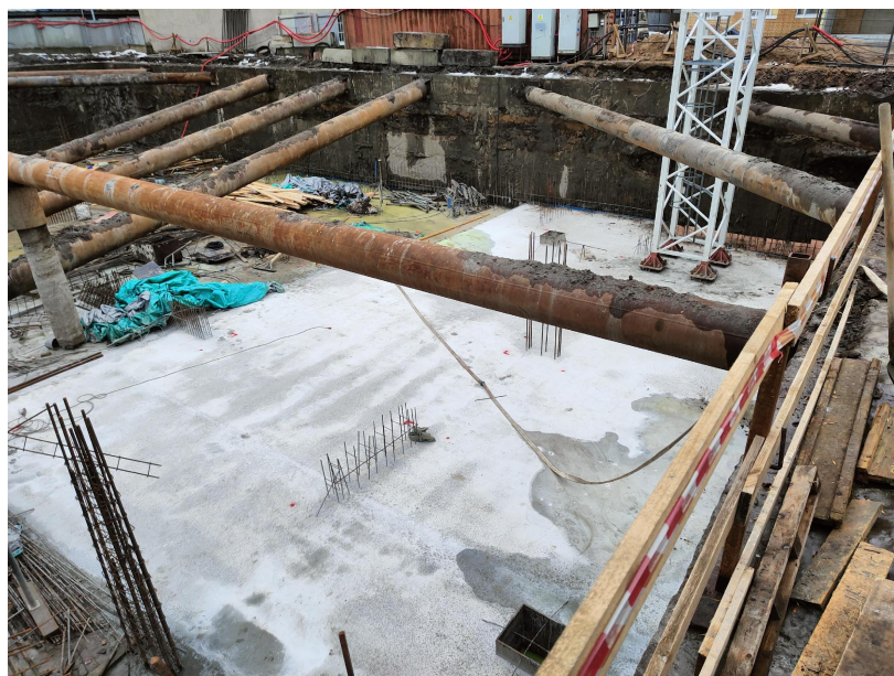
Бетонирование плиты ростверка в/о 17-26г/А1г-И
