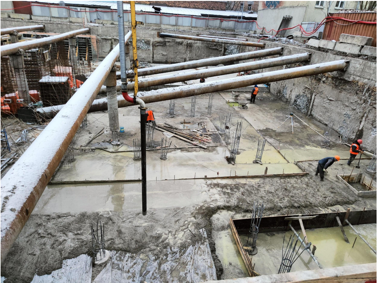
Устройство бетонной подготовки в/о 18-26/А1Г-Д
