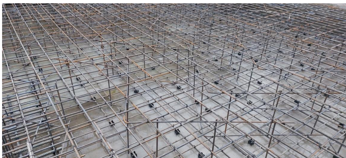
Армирование плиты ростверка
