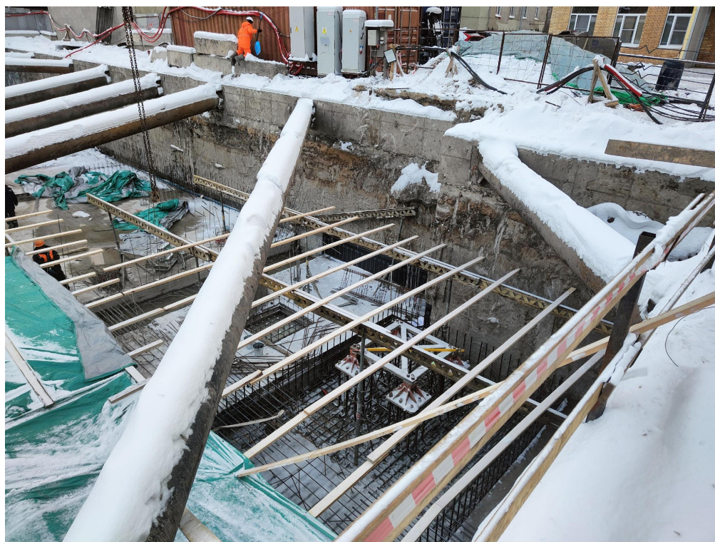
Армирование плиты ростверка в/о 17-26г/А1г-И
