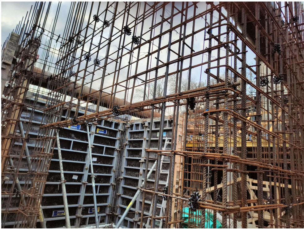
Армирование стен подвала
