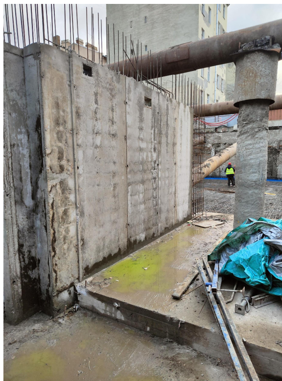
Бетонирование стен подвала
