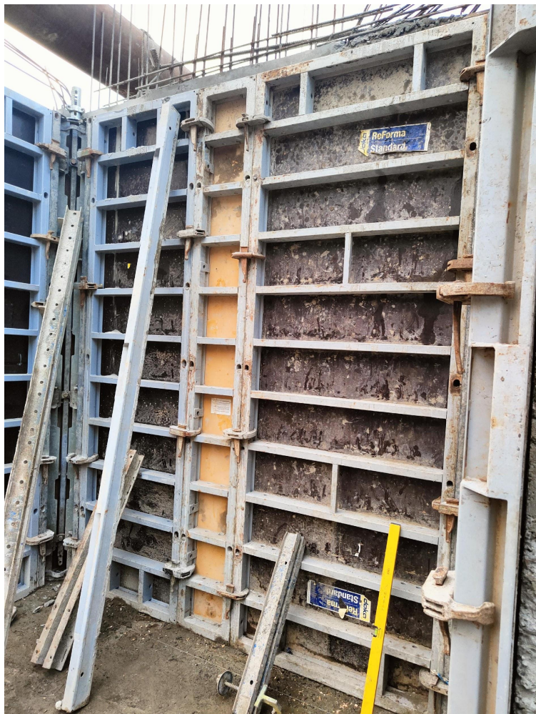
Устройство опалубки стен подвала
