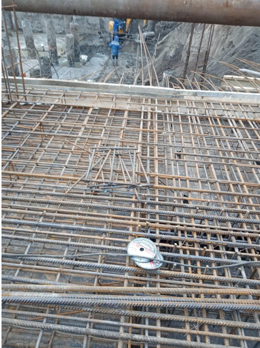
Армирование плиты перекрытия над подвалом в/о7-18/А1г-Д, откопка котлована и устройство основания в/о 18-26
