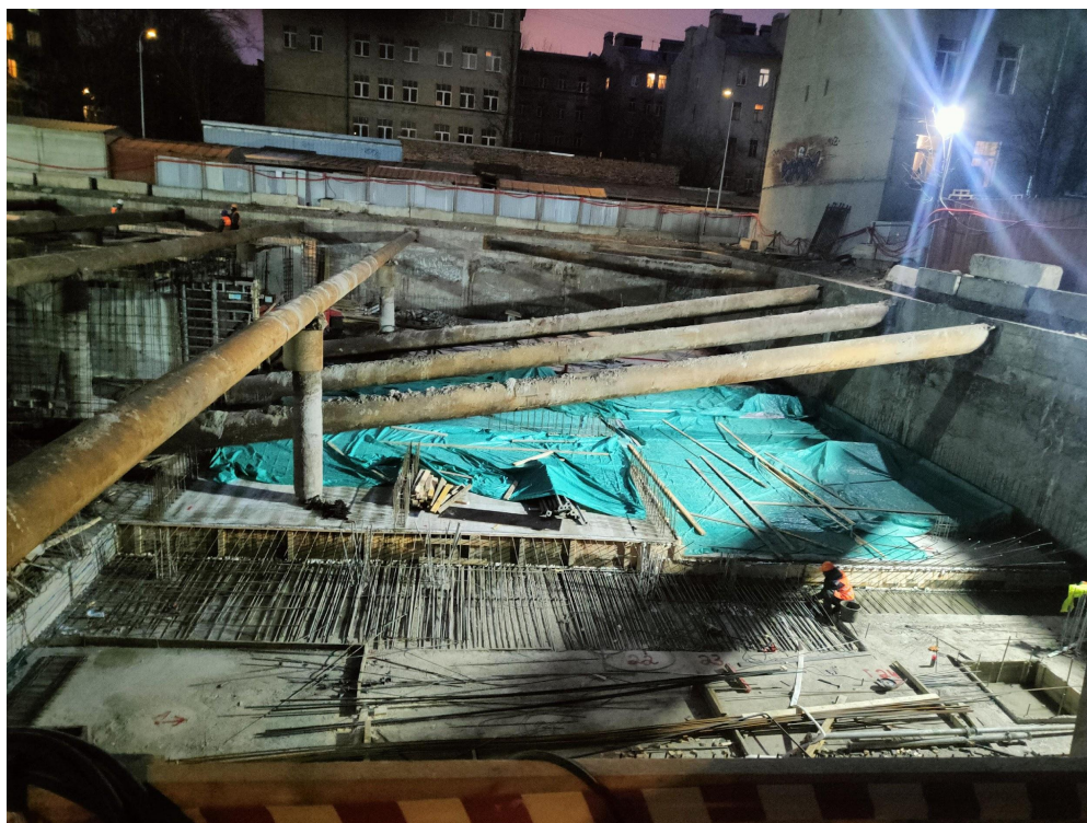
Бетонирование плиты ростверка в/о 17-26г/Д-М
