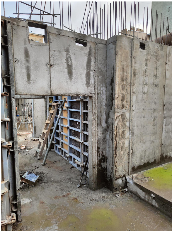
Бетонирование стен подвала
