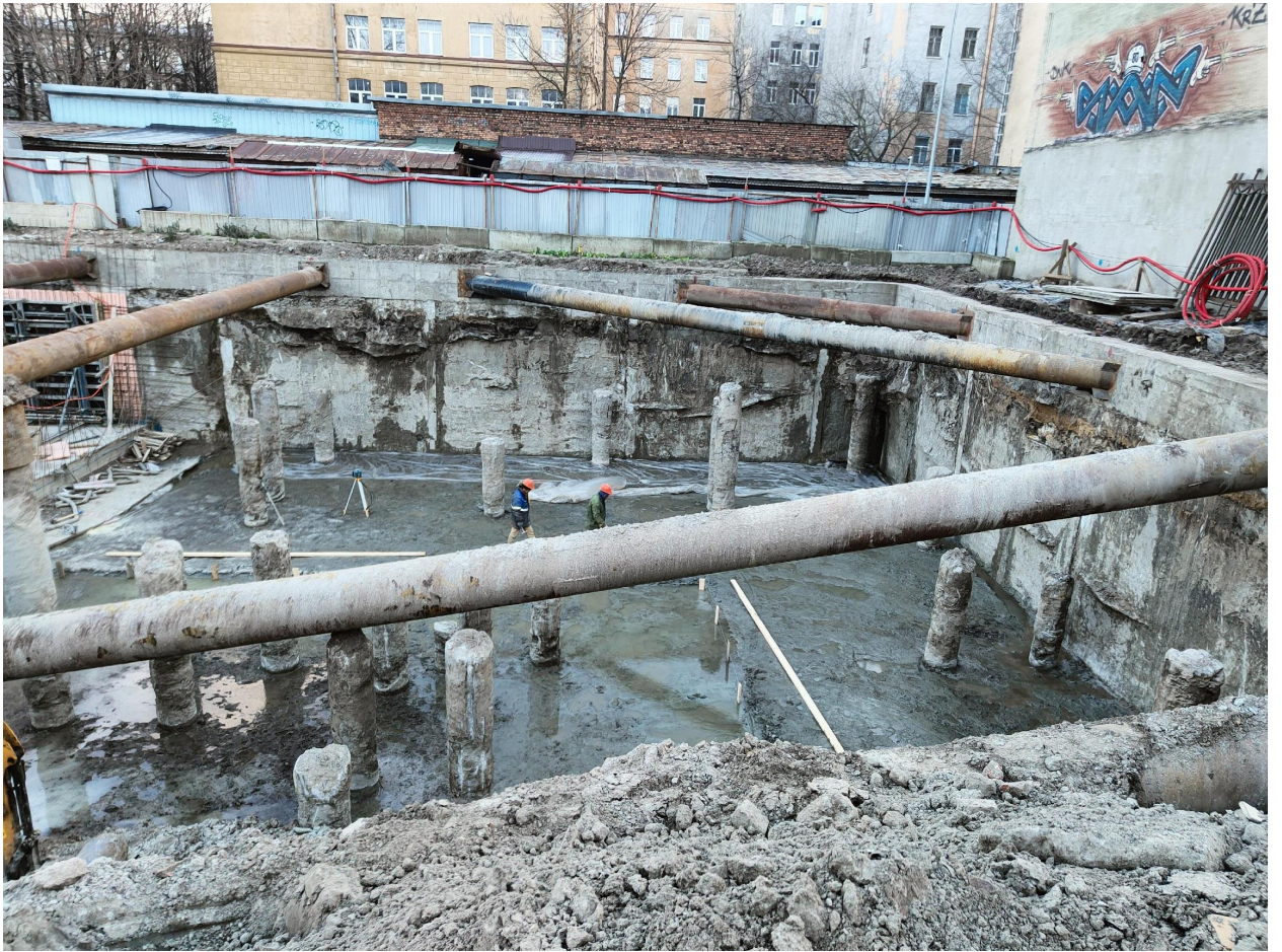
Устройство основания под бетонную подготовку
