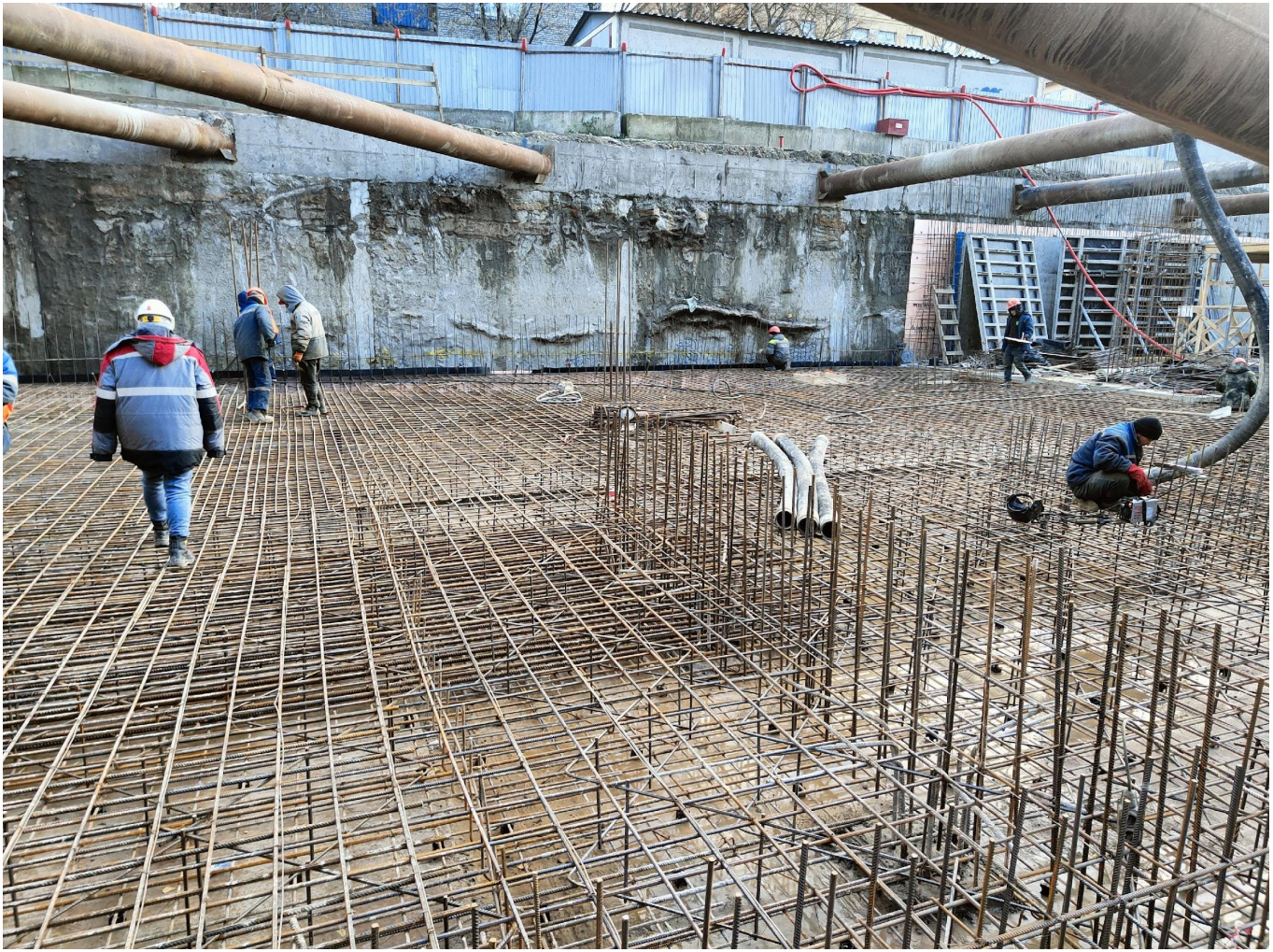
Армирование плиты ростверка
