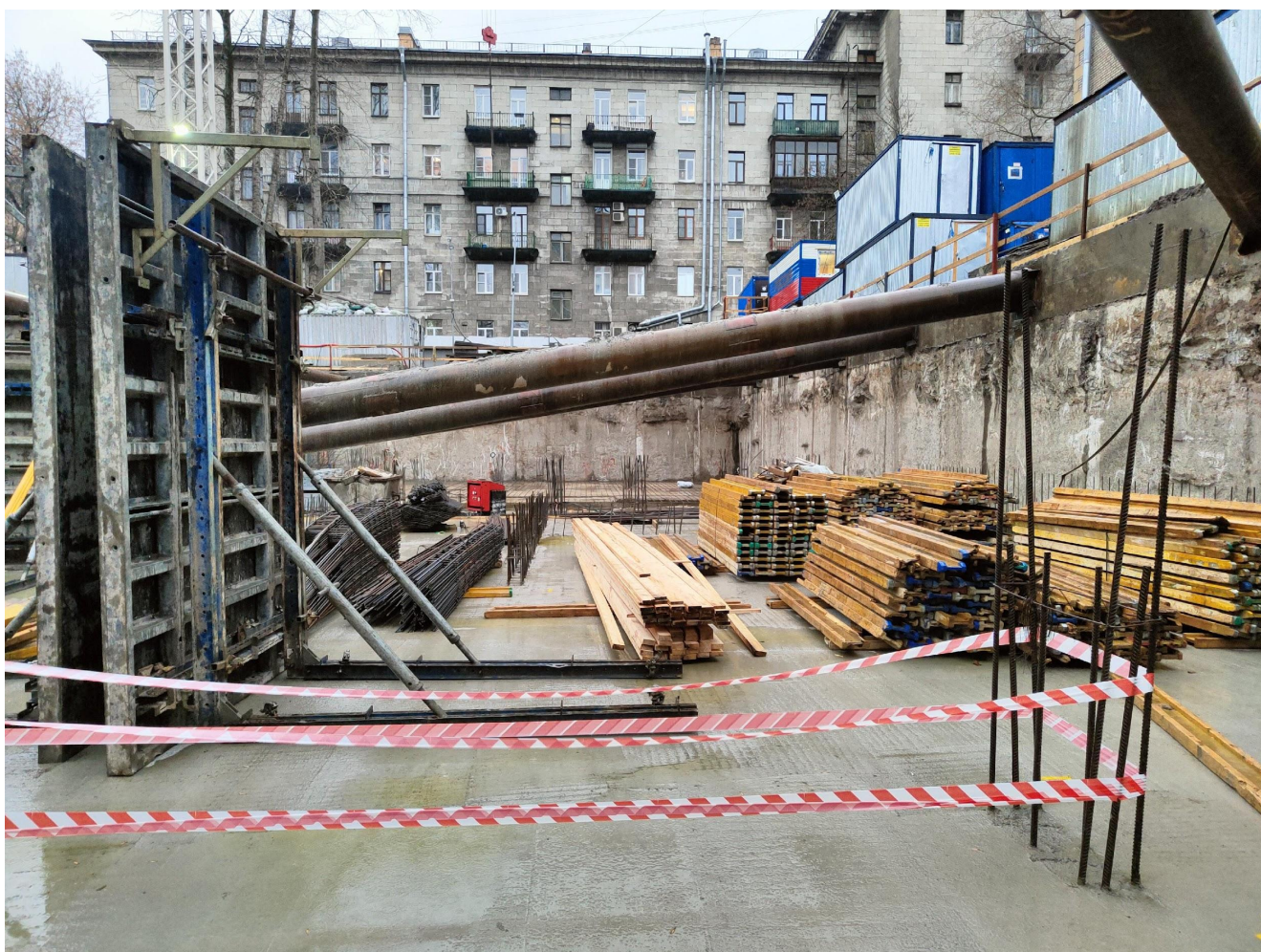
Бетонирование плиты ростверка
