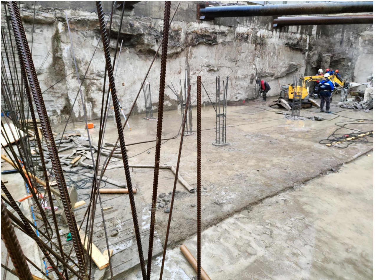
Устройство бетонной подготовки в12,5 и срубка оголовков свай
