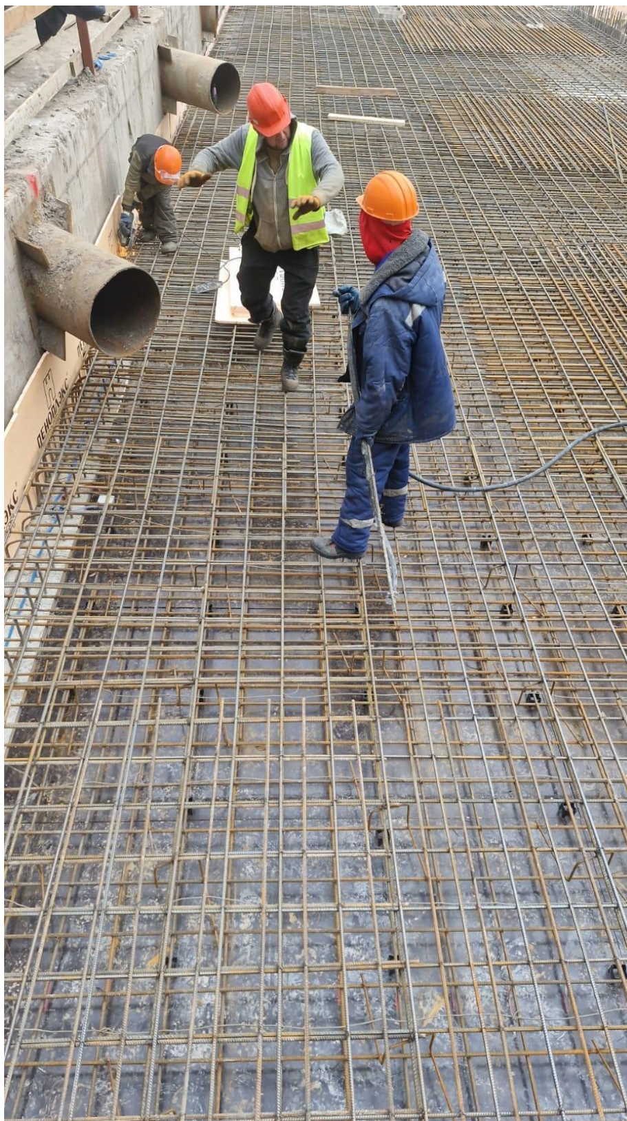
Армирование плиты перекрытия над подвалом в/о 1/1г-5/А/1г-Л
