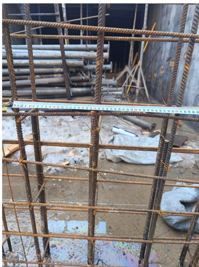
Армирование стен подвала
