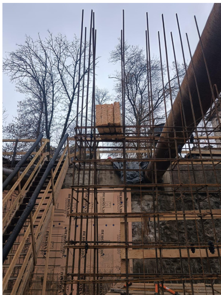
Армирование стен и колон подвала
