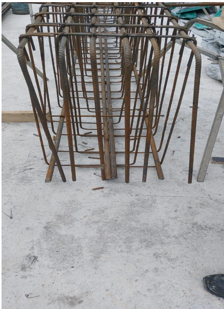
Армирование балки плиты перекрытия над подвалом
