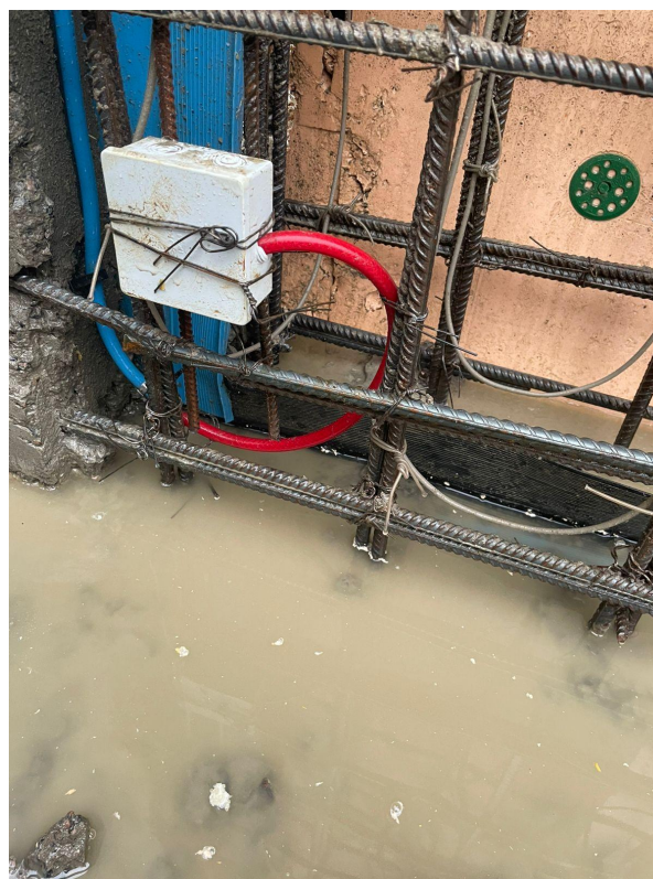
Армирование стен подвала и монтаж гидрошпонки и инжект системы
