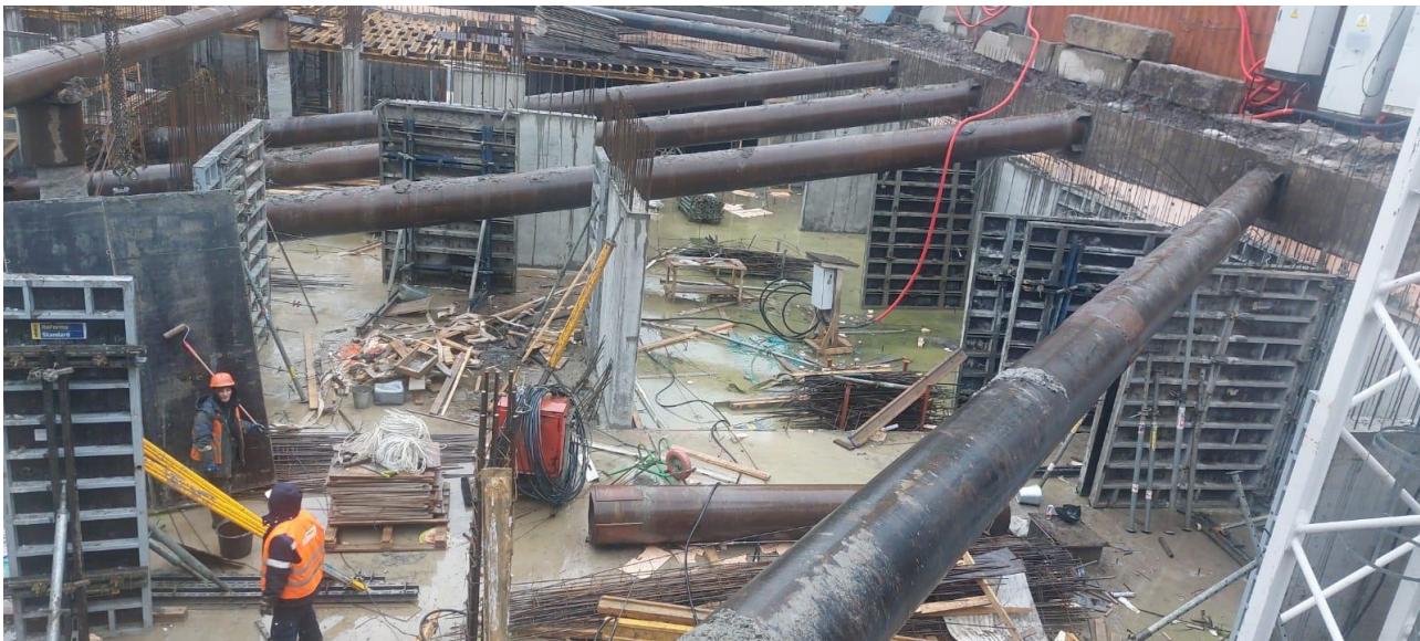
Устройство опалубки и бетонирование стен подвала
