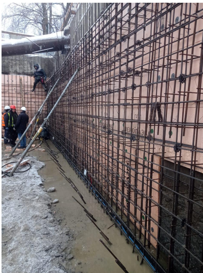
Армирование стен подвала
