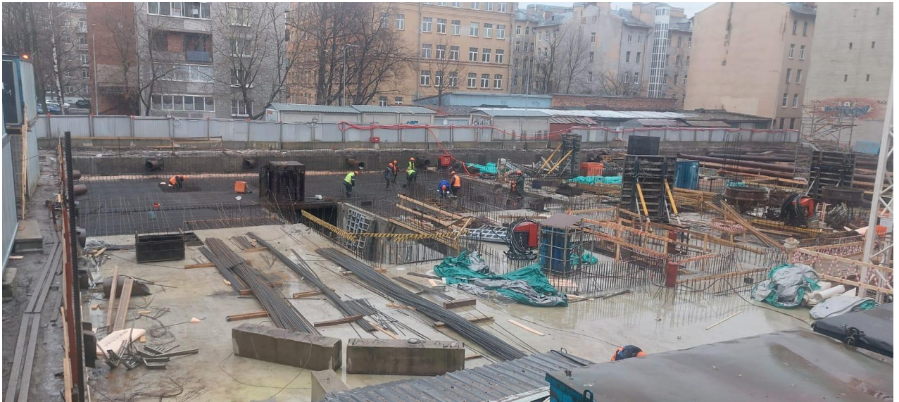
Бетонирование плиты перекрытия над подвалом в/о 1/1г-5/А/1г-Л
